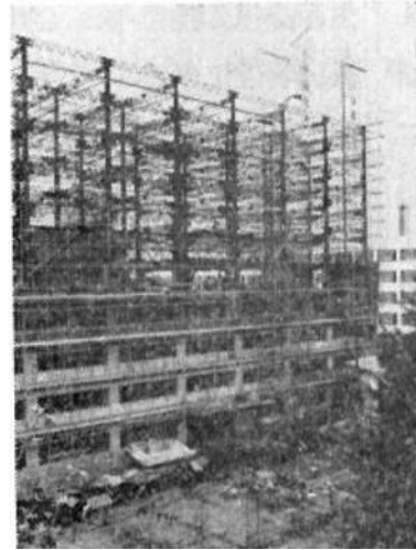
建設中の新中棟
